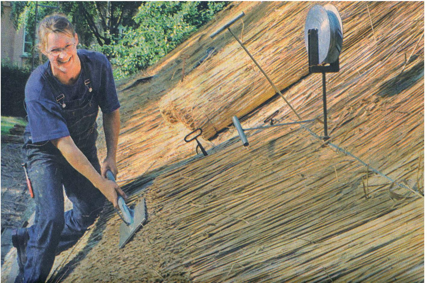
Praktikantin Arps übt das Eindecken mit Reet an der Traufe des Dachstuhls eines alten Bauernhauses. Das Hochklopfen der mit Spanndraht vernähten Bunde mit dem sogenannten Treiber verleiht den Dächern ihr charakteristisches Aussehen.
